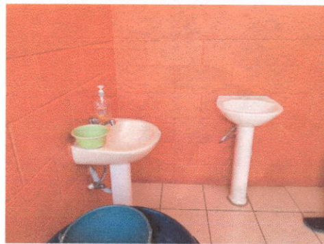
Foto 10: Vista lavamanos en baño mujeres
